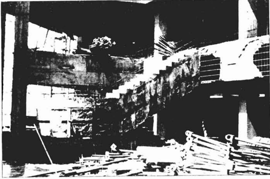
شكل (٥) : جزء من أضرار بلاطة الدور الأول والدرج الموصل له
