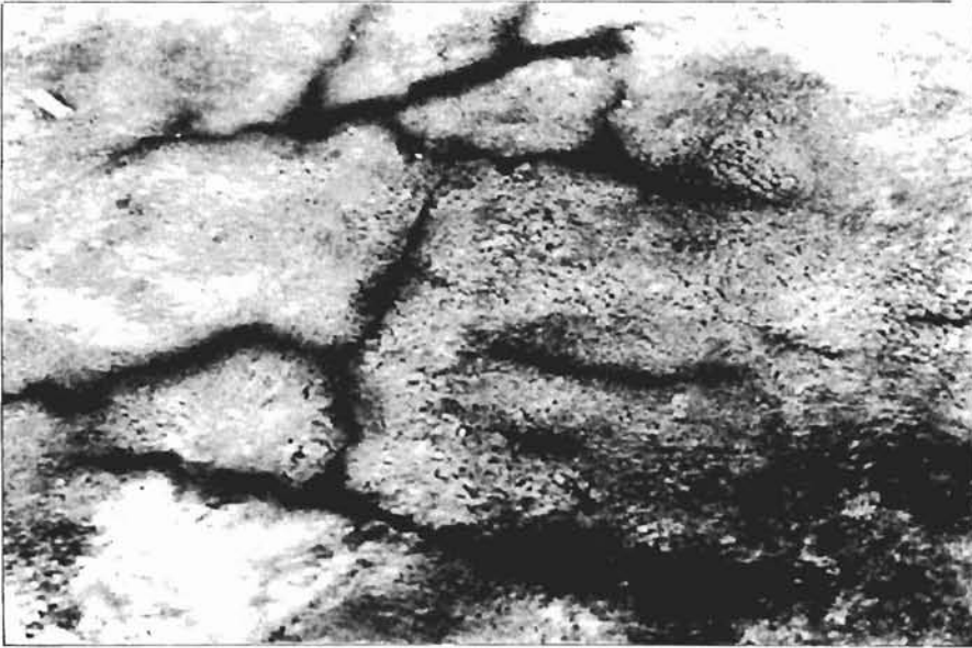
شكل (٧) : التشققات في وجه البلاطة العلوية للدور الثاني
